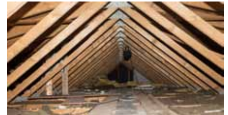
So sah es vorher aus im Dachboden des Vereinsheims an der Donau
