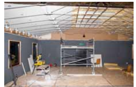
Zwischenstand: Die Dachkonstruktion ist gut sichtbar. Links ist die Dachinnenfläche bereits isoliert. Für die Arbeiten wurde ein mobiles Gerüst genutzt
